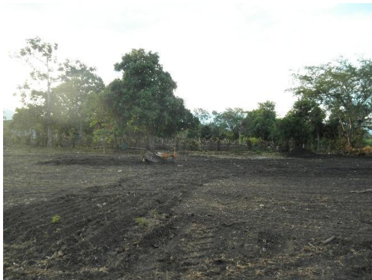
Figura 11. Lote en preparación con pases de rastra.
