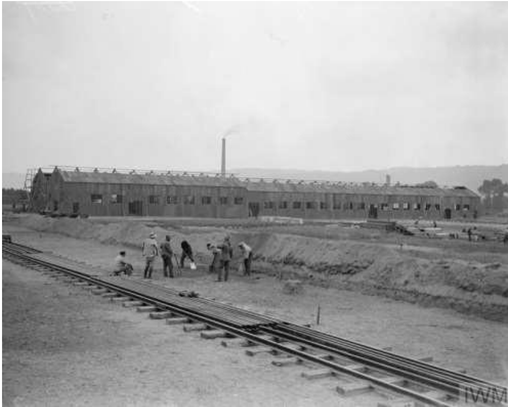
Imagen 11. Miembros del Cuerpo de Trabajo Chino realizan reparación de vías férreas, 1918.
