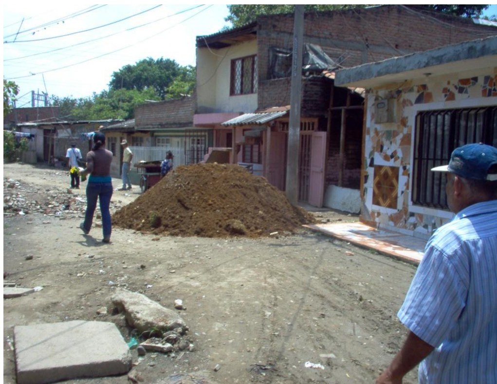
Figura 25: Viviendas construidas en la berma
