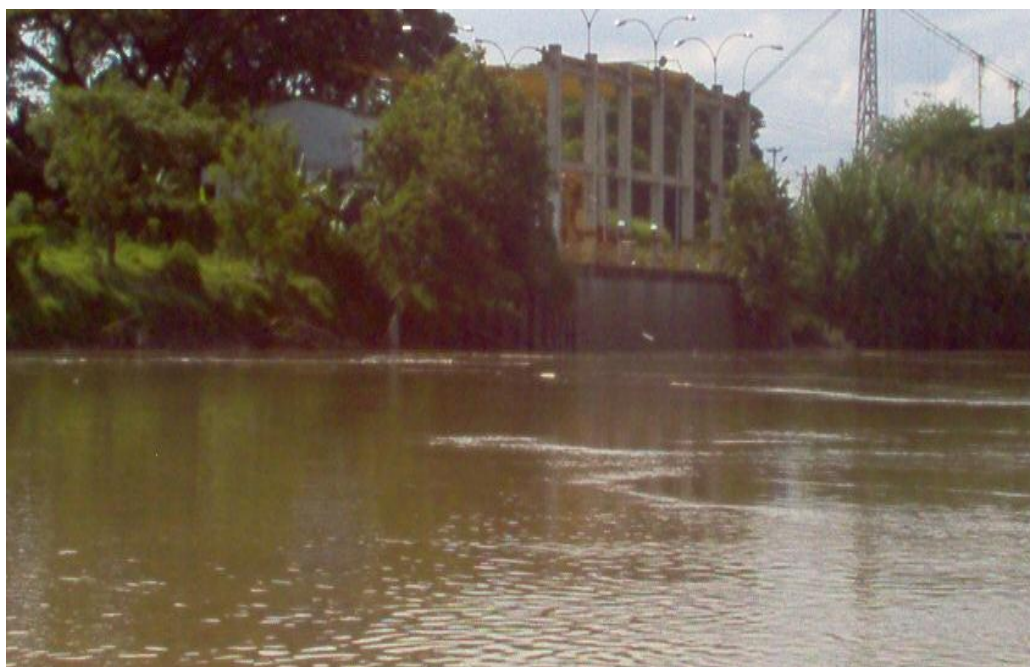
Figura 26: Planta de Tratamiento de agua potable de Puerto Mallarino
