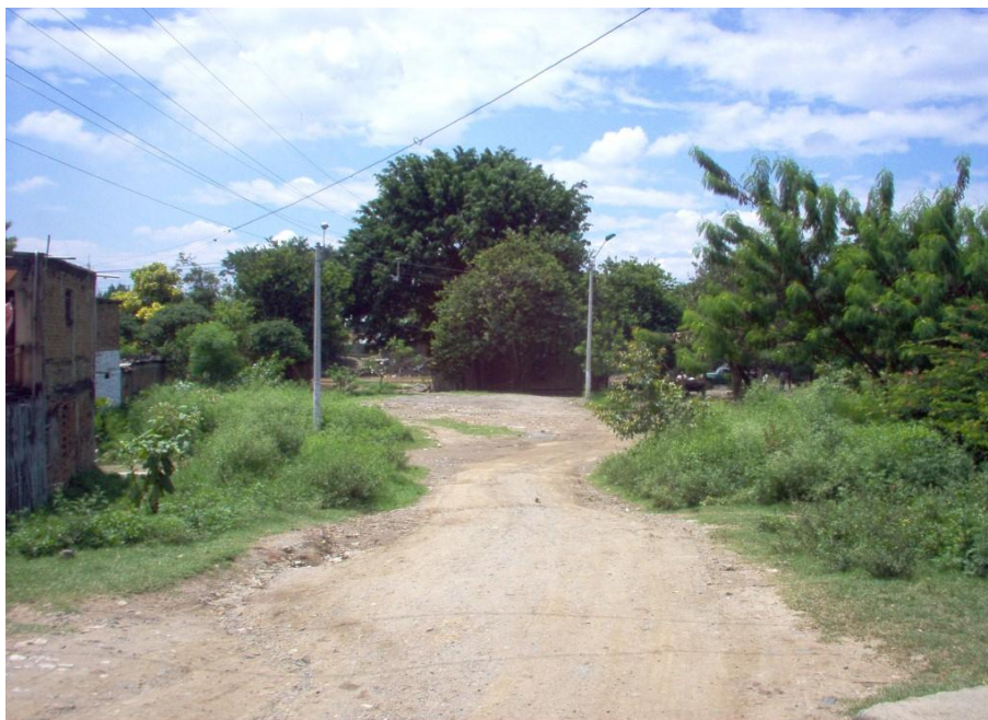
Figura 23: Corona del dique
