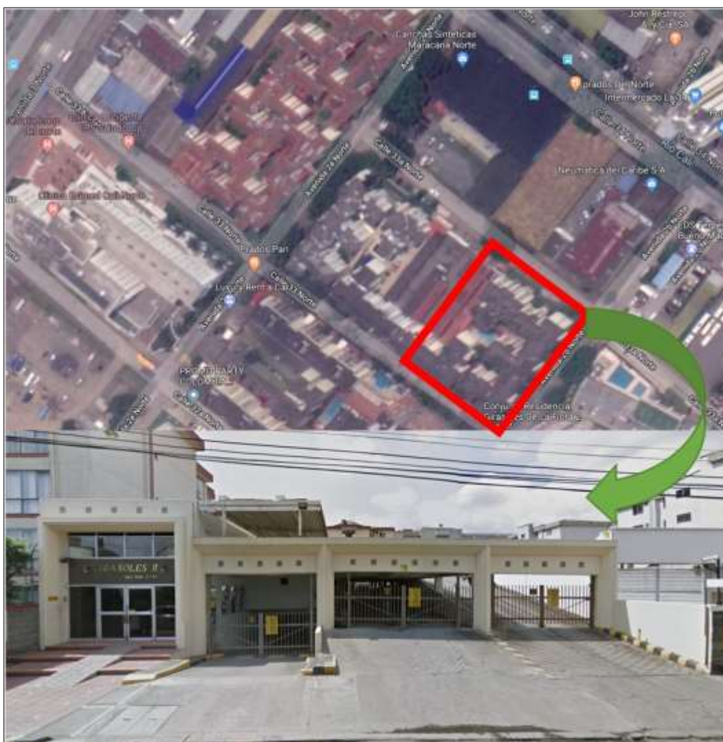
Figura 1. Localización general conjunto Residencial Girasoles de la Flora II Fuente: Google Earth
