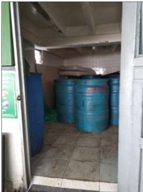
Figura 6. Enchapado interior de la UAR
