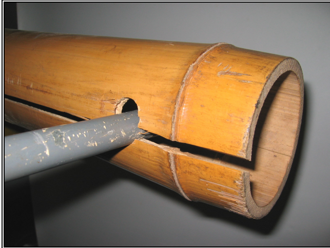
Figura 2.14 Falla inducida por hueco para tubo de aluminio.
