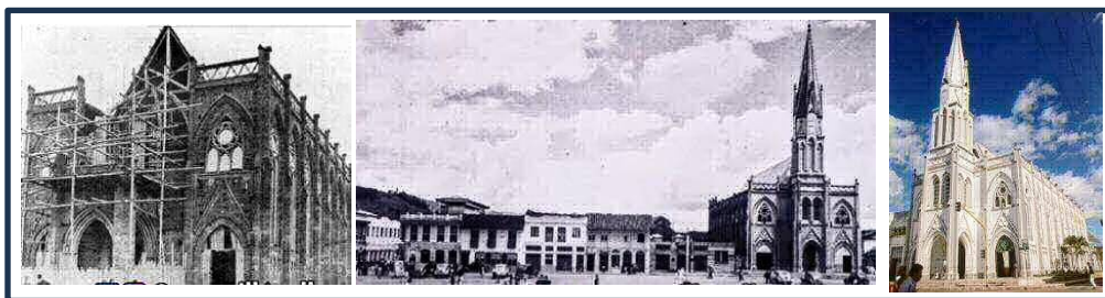
Imagen 46. De derecha a izquierda: Fachada en construcción Iglesia Sevilla, aprox década de los 30s siglo XX; Fachada sobre la plaza principal, sin fecha; Fachada principal Iglesia de Sevilla, sin fecha.
