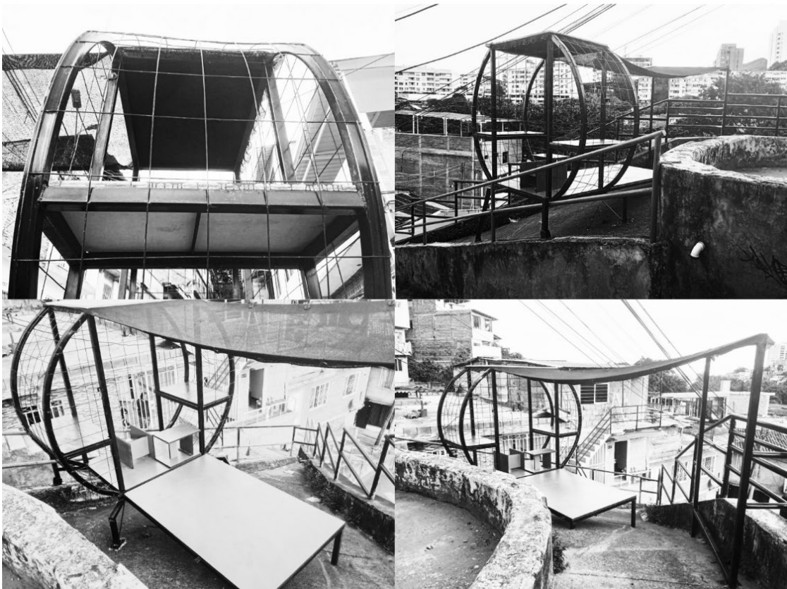
Fotografía 5. Construcción de prototipo.
