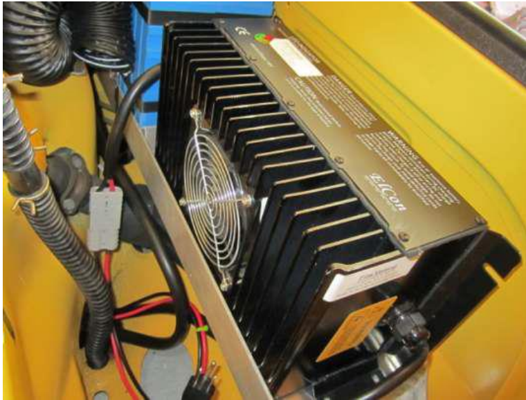
Figura 24. Instalación de cargador de baterías
