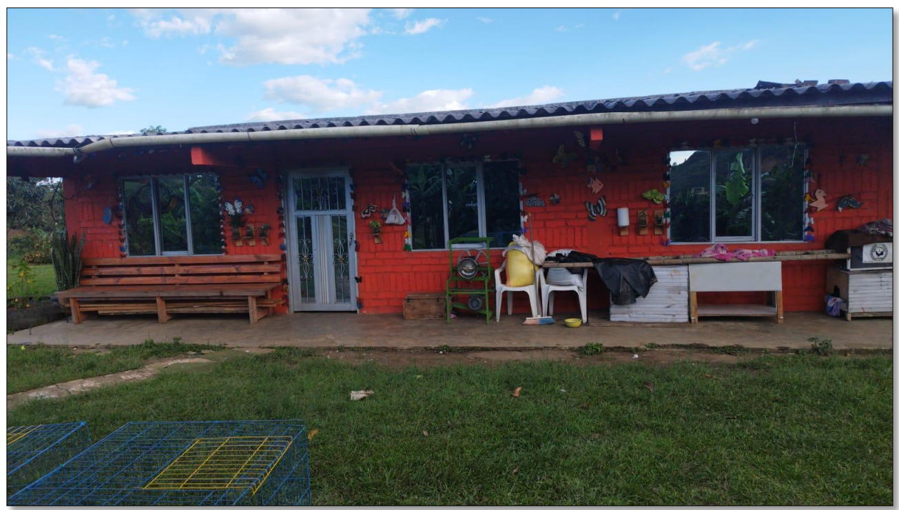
Figura 24. Vista lateral de la vivienda
