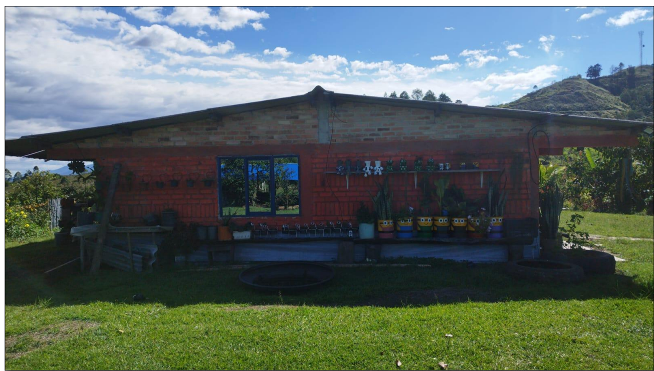
Figura 23. Vista frontal de la vivienda
