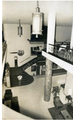
Fotografía 3: Interiores de la entrada del Hotel Aristi, 1980. Autoría: Diario Occidente. 89
