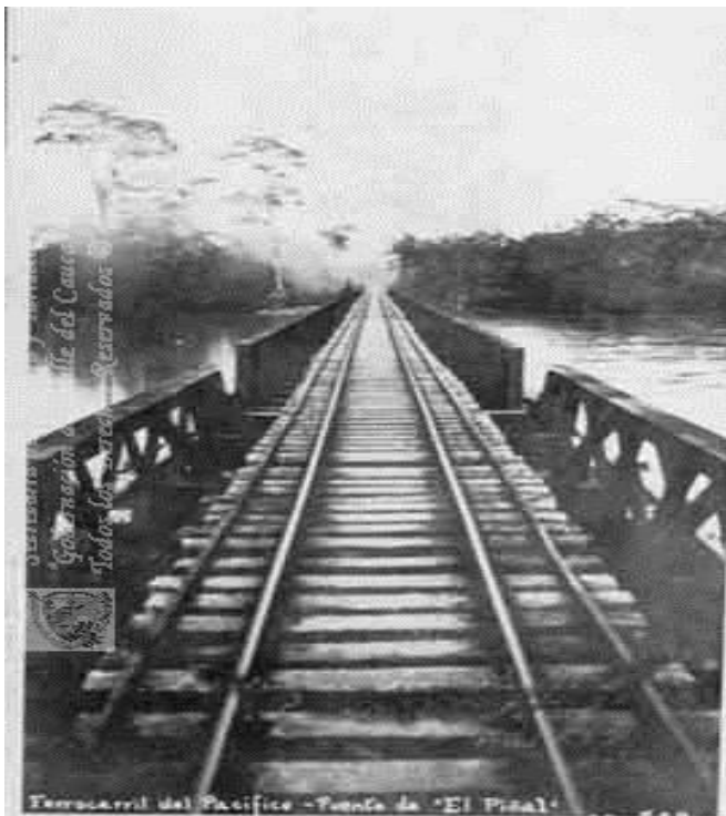
Foto N°2. Puente de El Piñal, posteriormente cambiado por uno más estable de ferroconcreto. Fuente: Archivo del patrimonio fílmico y fotográfico del Valle del Cauca.
