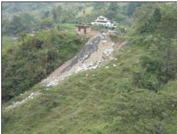
Foto 4-2 Restos de estopas abandonadas en un talud
