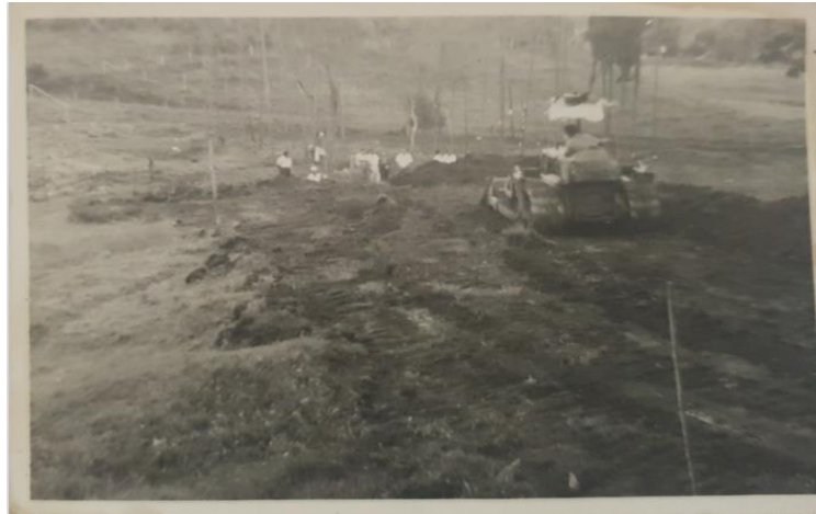
Ilustración 3: Inicio de obras en el Club de caza y pesca.
