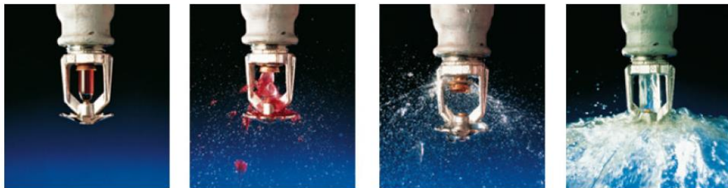
Figura 3. Secuencia de activación de un rociador.
