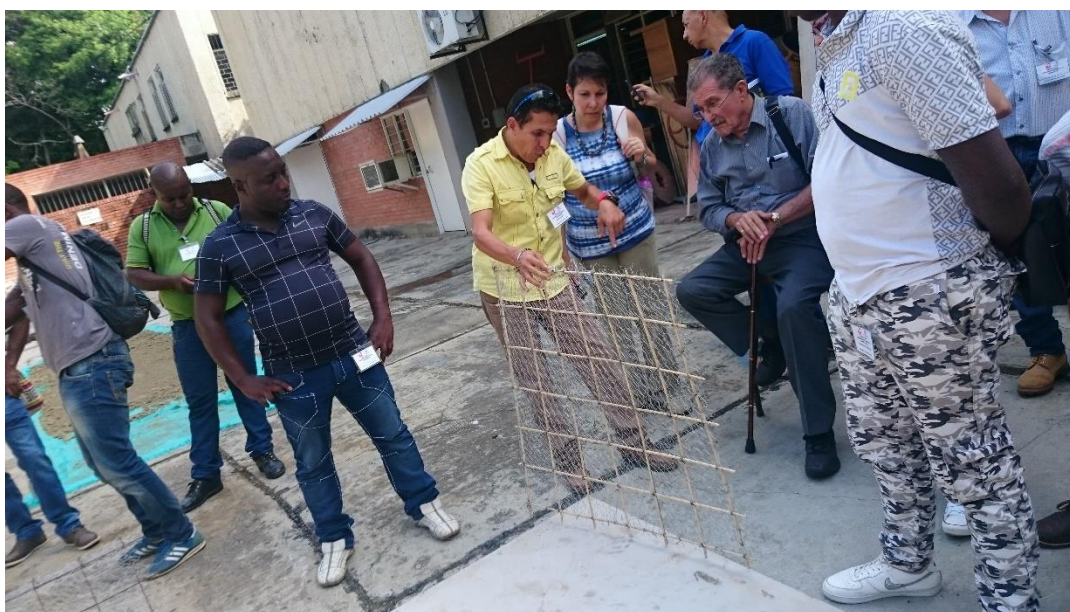
Preparación de la armadura de una placa en ferrocemento para panelería
