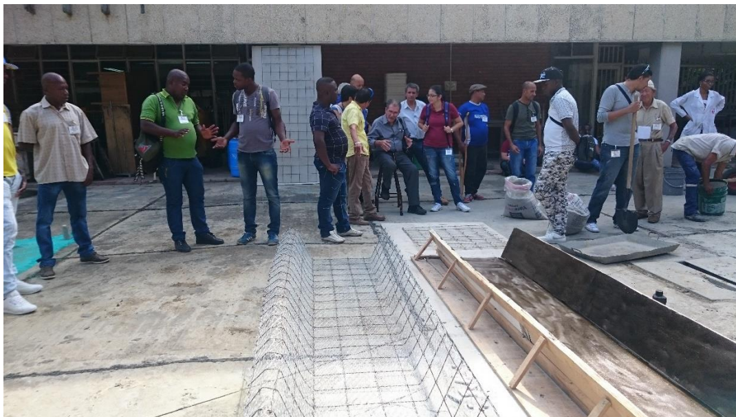
Preparación de la armadura de una canaleta en ferrocemento
