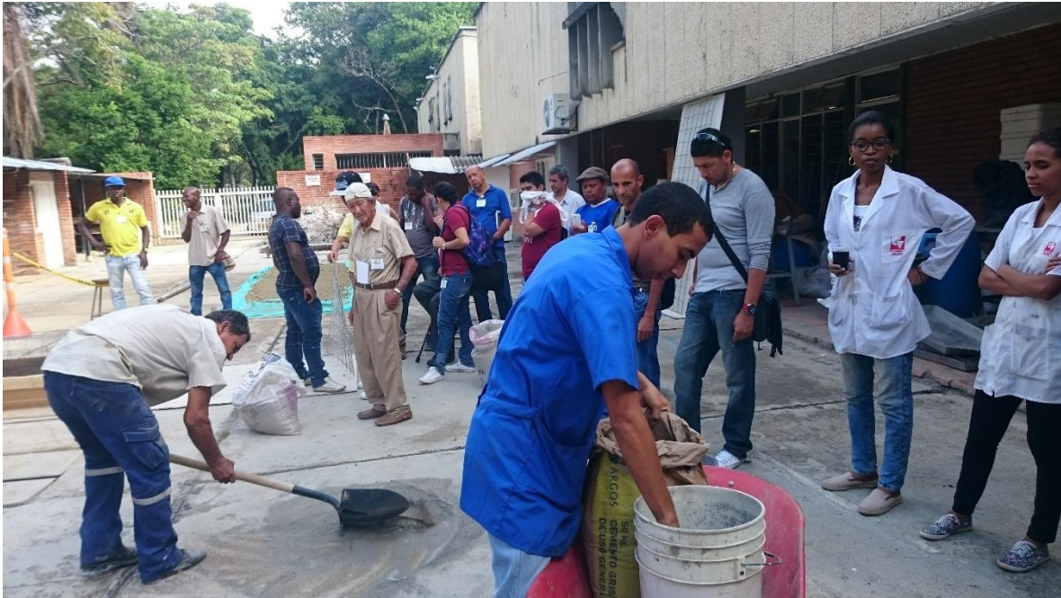
Preparación de la mezcla cementicia
