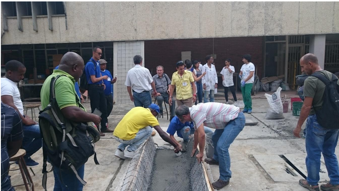
Moldeado de una canaleta de ferrocemento
