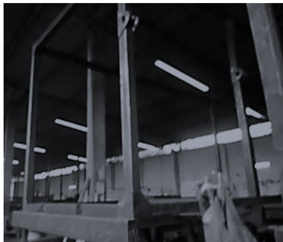
Figura 5.5. Estructura de canasta armada. Tomada de la empresa de producción del equipo de transporte
