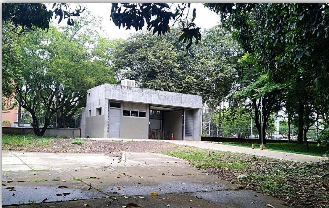
Imagen 7 : Nueva Portería Peatonal - Univalle
