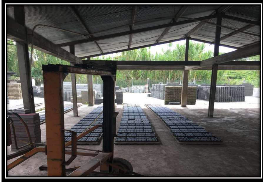
Ilustración 17. Patio de curado Fuente. Elaboración propia.
