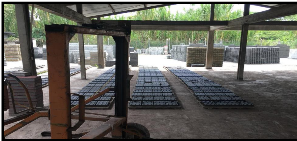
Ilustración 11. Patio de curado Fuente. Elaboración propia.
