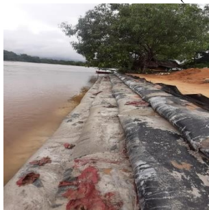
Muros con bolsas rellenas con concreto
