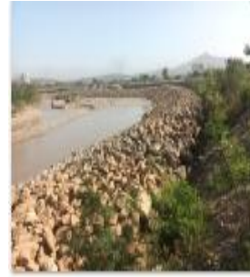
Muros en enrocado natural (Rip-Rap)
