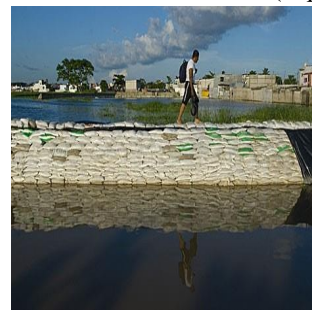
Muros con bolsas llenas de arena
