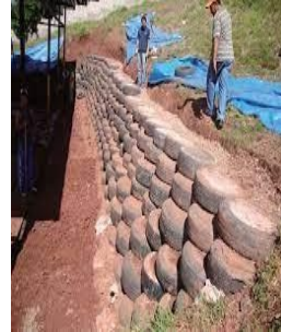
Muros con llantas usadas
