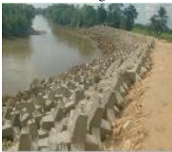
Muros en enrocado artificial (hexápodos)
