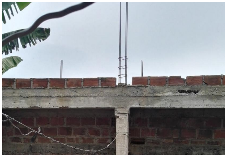
Imagen 3. Segundo piso en construcción - Vivienda 370
