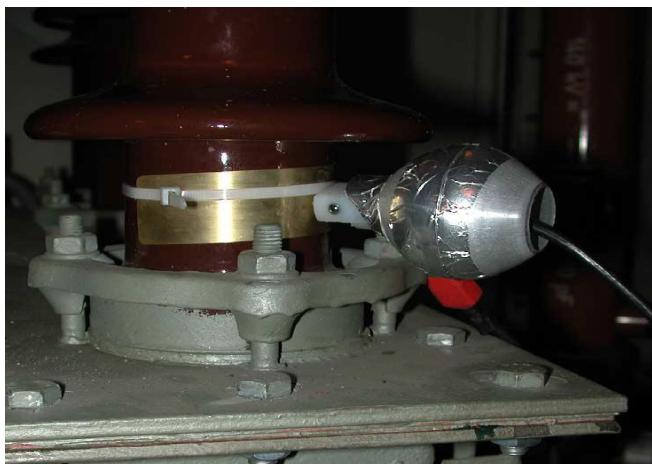
Figura 4-3. Instalación de sensor para la medición de \tan \delta y factor de potencia
