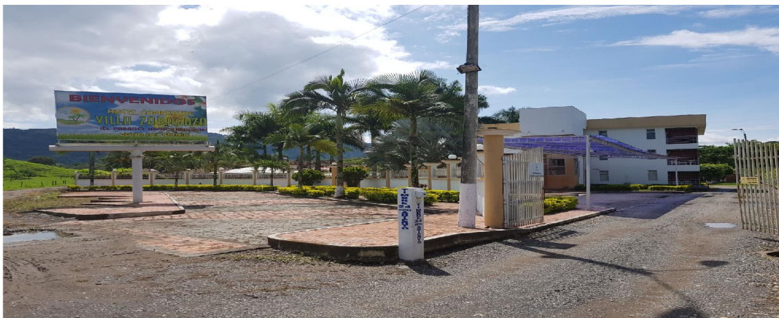
Fotografía 5. Entrada del Hotel Villa Zaragoza
