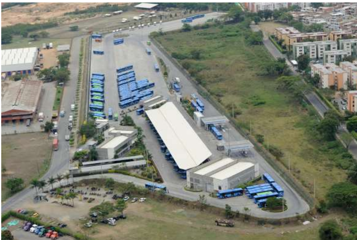
Figura 6. Patio Taller Calima Sameco. Fuente: Metro Cali S.A. (2014)
