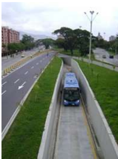
Figura 1. Corredor troncal. Fuente: Metro Cali S.A. (2016).
