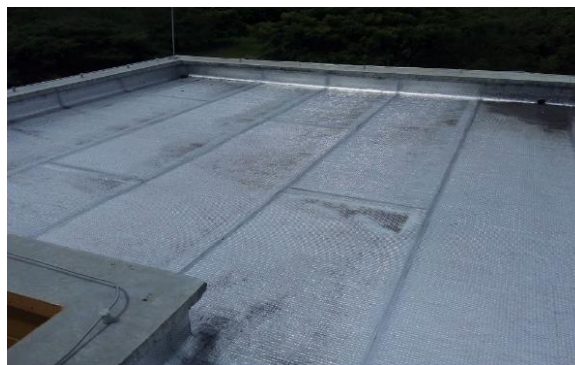
Ilustración 7 Cubierta de aulas
