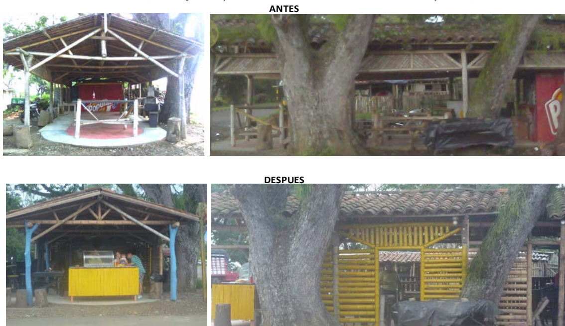
Ilustración 5. Antes y Después Fachada Local "K'liche Piqueteadero"
