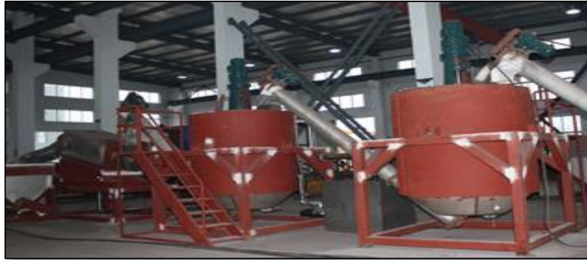
Ilustración 21. Tanque de agua caliente
