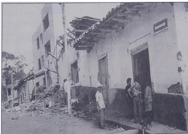
“inspeccionaron daños materiales en población” Tomado de: Diario del Sur , 19 de abril de 2002
