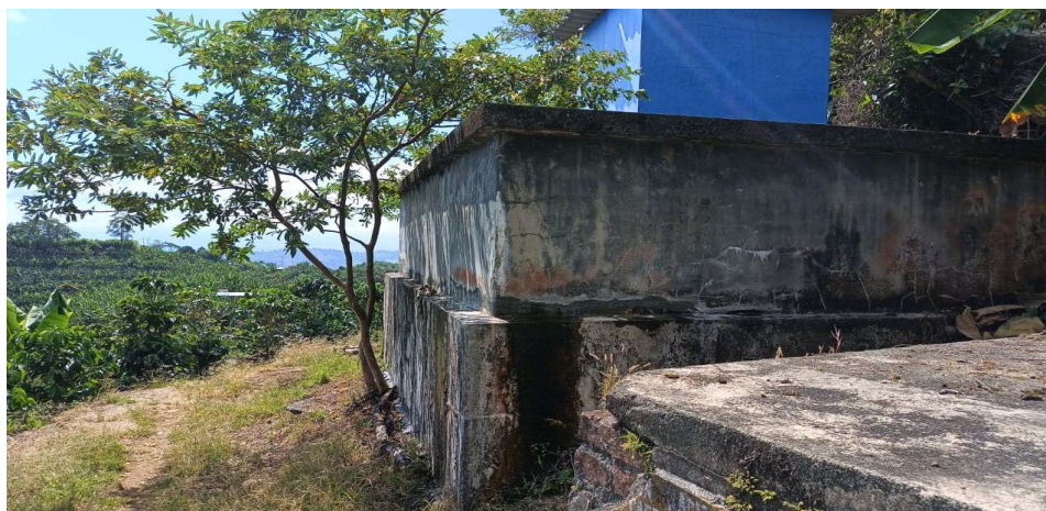
Figura 2: Acueducto vereda Morroplancho fuente propia.
