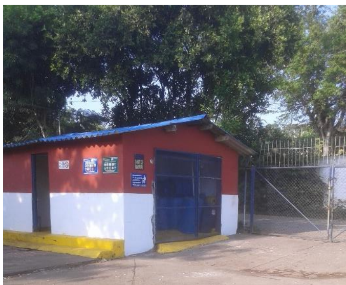
Figura 27. Unidad de Almacenamiento de Residuos – UAR y acceso para el vehículo recolector
