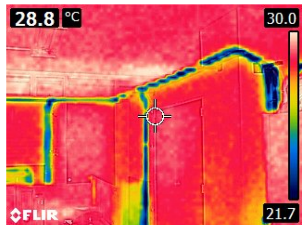
(b) Paredes Sur y Oeste.
