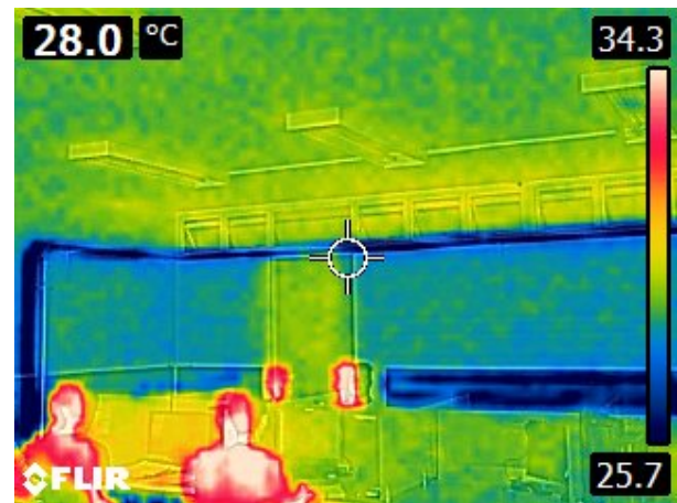
(b) Paredes Este y Sur.
