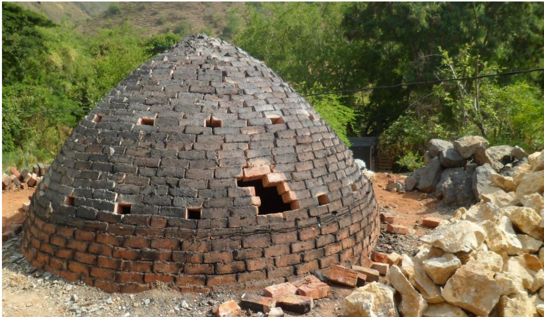
Figura 35. Cúpula del horno vertical tipo colmena para la producción de cal
