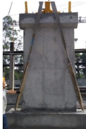
Fundición de la viga superior y transporte de los muros
