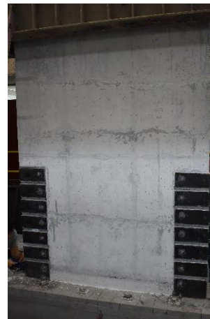
m) Reforzamiento muro M7RR
