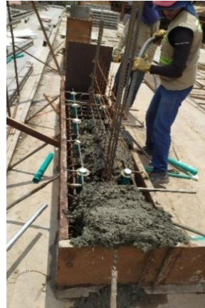
Encofrado, armado de refuerzo y fundición de la cimentación
