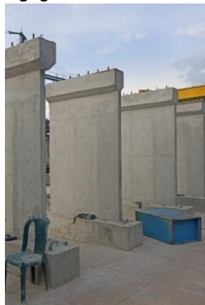
Fundición de la viga superior y transporte de los muros
