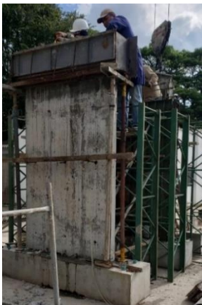
Instalación de galgas internas en el refuerzo, encofrado y fundición de los muros
