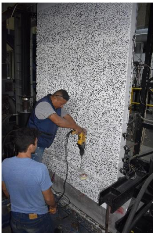
k) Perforación del concreto para pernos de anclaje
