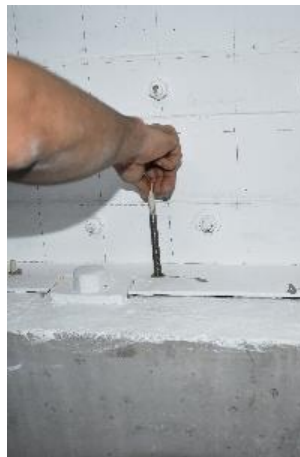
l) Anclaje de barras en la cimentación
