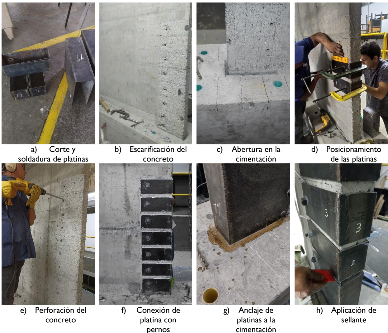
Figura 8.3. Procedimiento para el reforzamiento.
