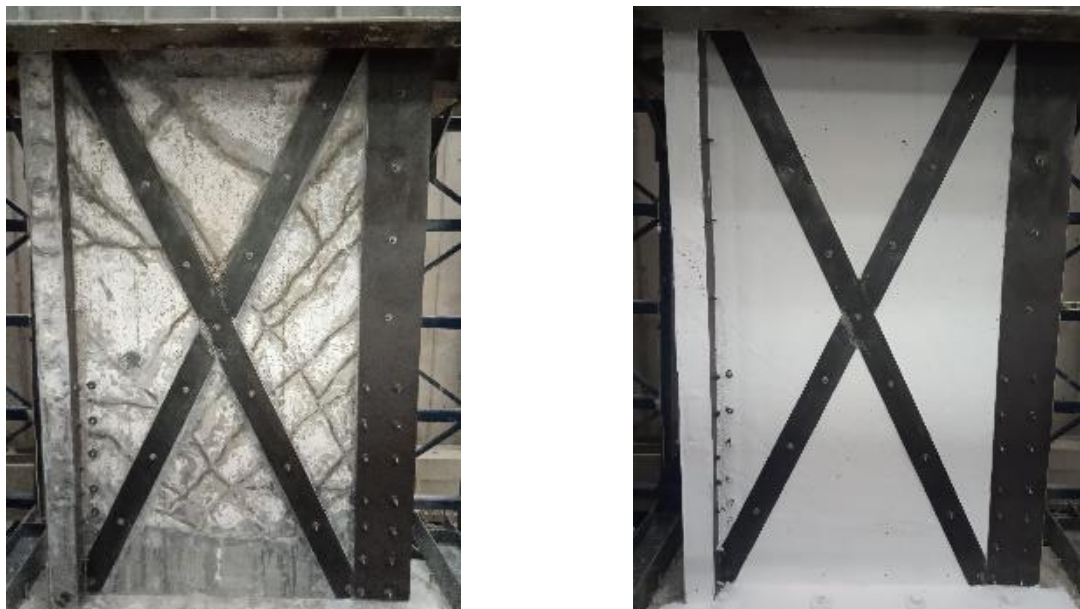
Figura 3.1. Reforzamiento del muro M2TRR ensayado por Ortega [1].
