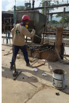
Encofrado, armado de refuerzo y fundición de la cimentación
