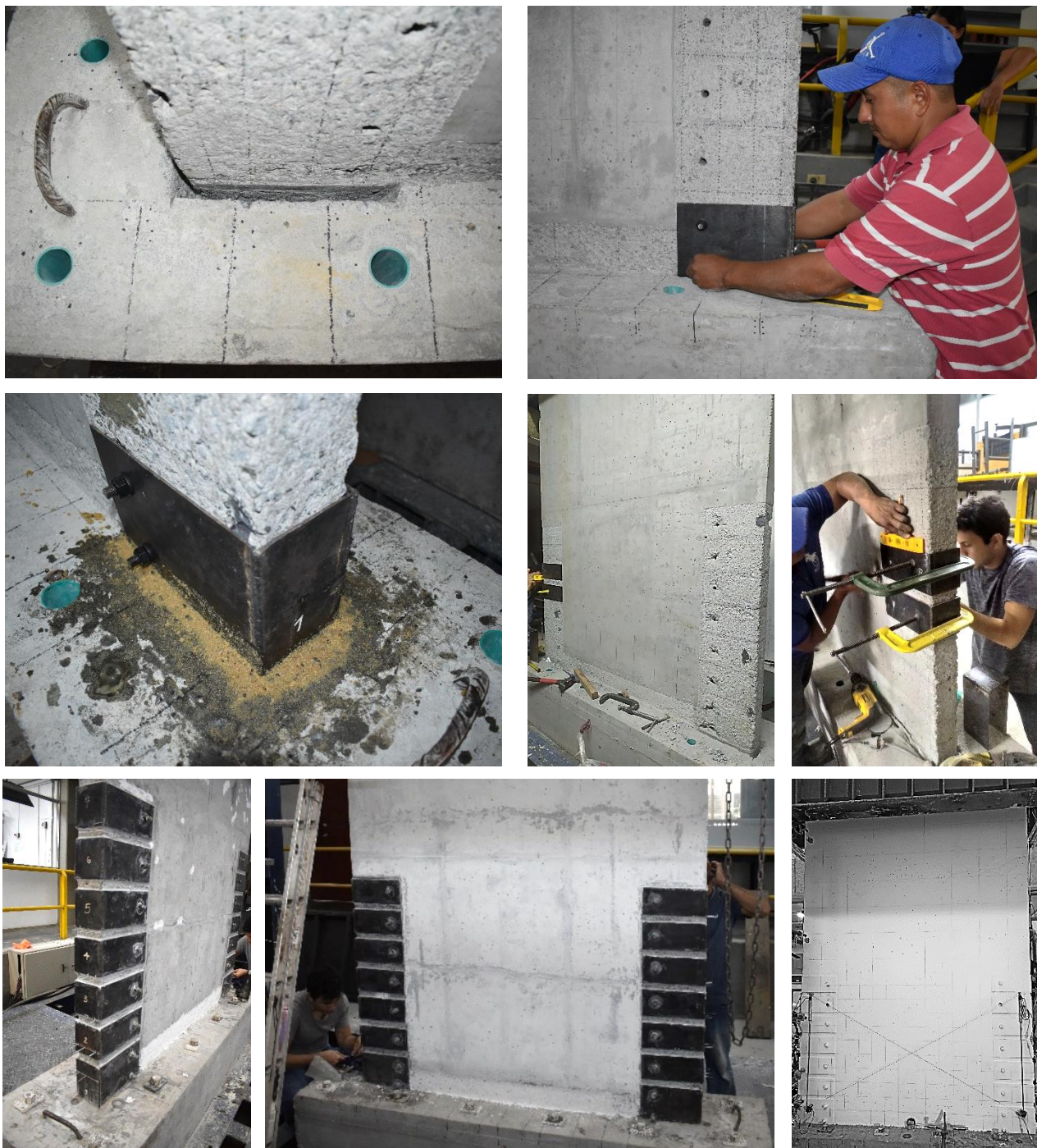
Figura 4.5. Proceso de reforzamiento del muro M7RR.
