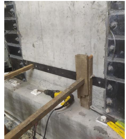
j) Confinamiento de la zona inferior del alma
