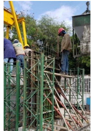
Instalación de galgas internas en el refuerzo, encofrado y fundición de los muros
