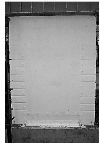
n) Reforzamiento muro M8RR
