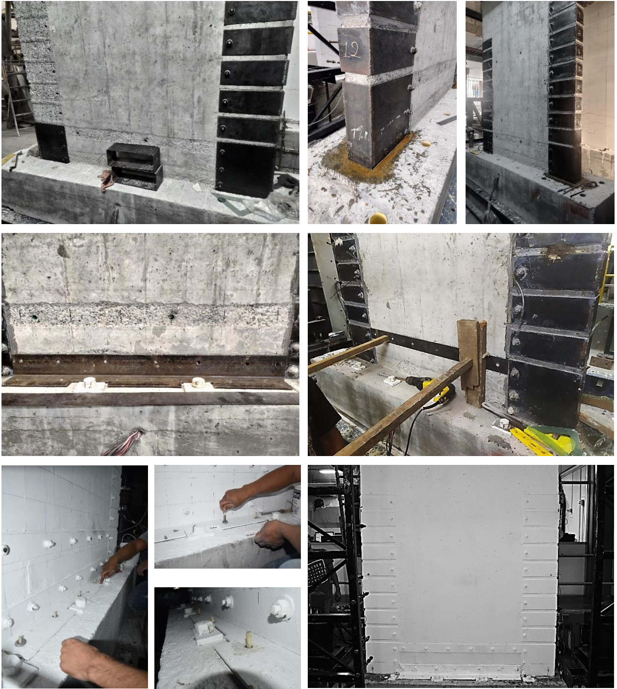
Figura 4.6. Proceso de reforzamiento muro M8RR.
