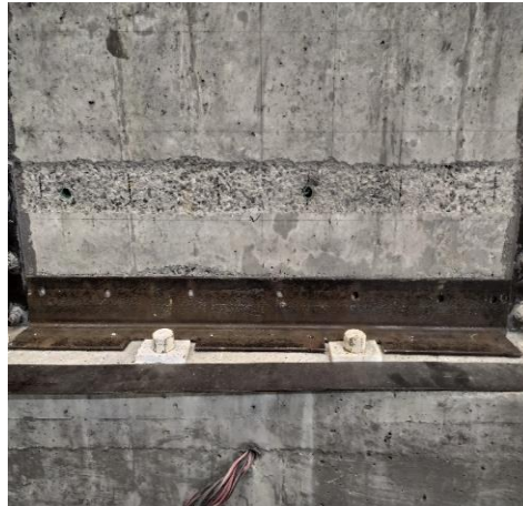
j) Confinamiento de la zona inferior del alma
