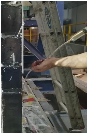
i) Aplicación de resina
