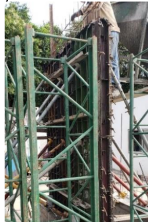
Instalación de galgas internas en el refuerzo, encofrado y fundición de los muros
