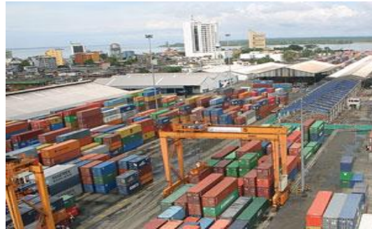
Figura (4) Zona de descarga
