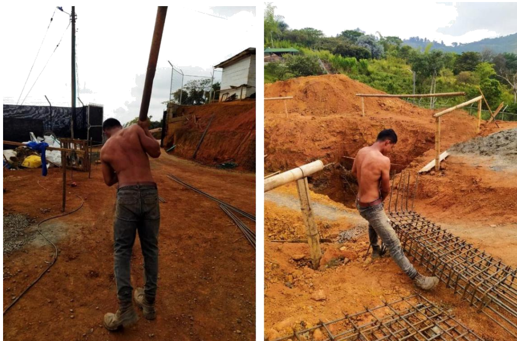
Fig. 11 levantando barra metálica- columna armada. Fuente: fotografía propia.
