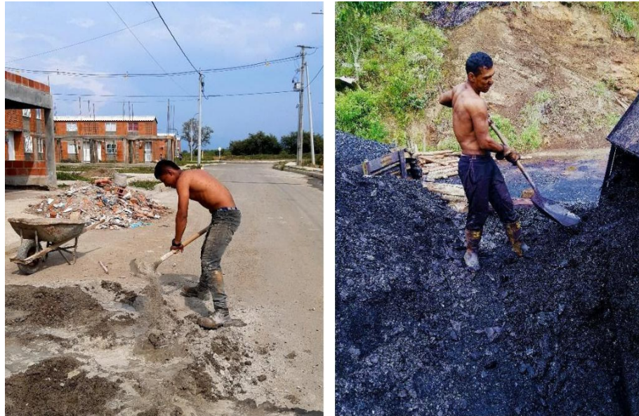
Fig.10.Uso de la pala, construcción y minería. Fuente: fotografía propia.
