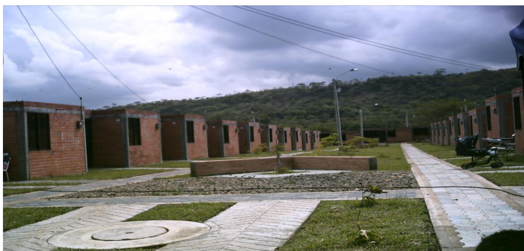
Urbanización Calama terminada: viviendas y espacios comunes
