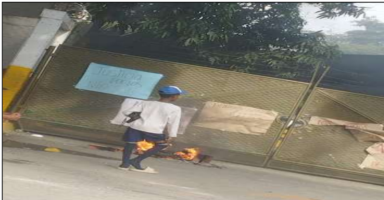
Figura 24. Entrada principal del CSIHSCD al día siguiente de la vandalización perpetrada
