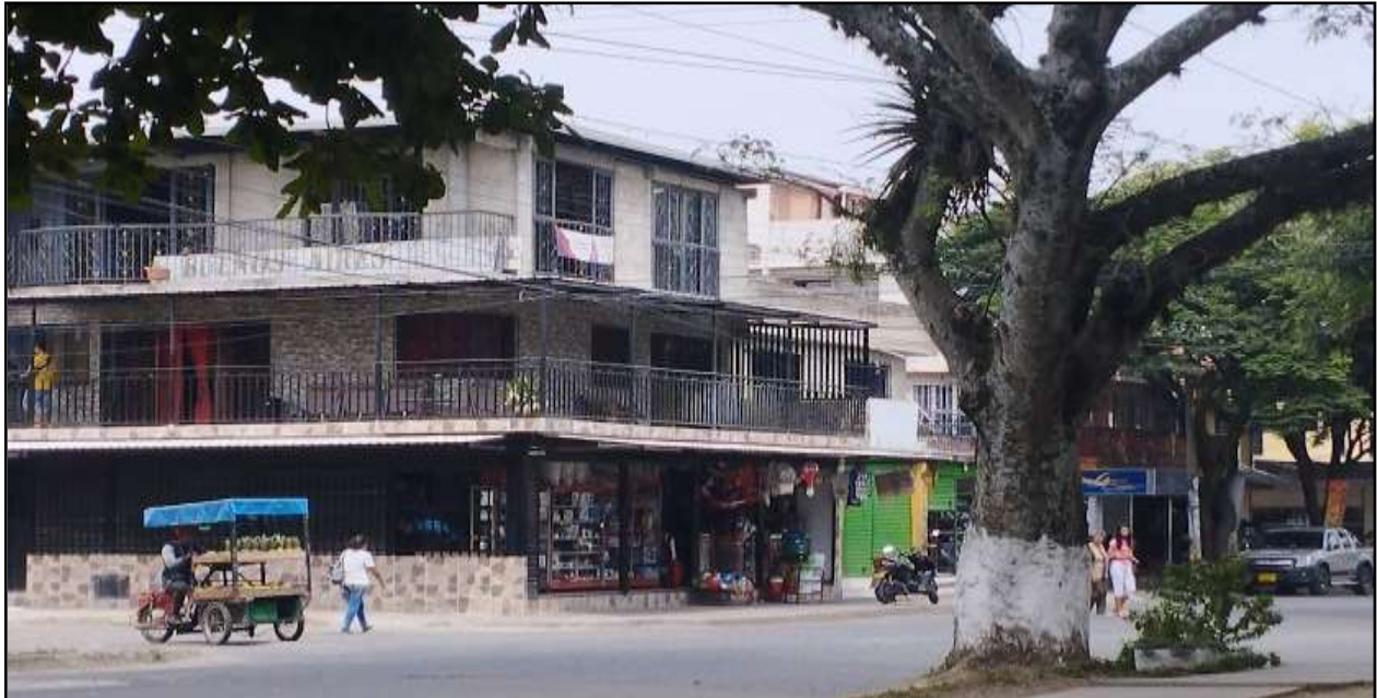
Figura 10. Vivienda de tres pisos localizada en la Carrera 26m3 con Calle 121-122, barrio Calimio Desepaz
