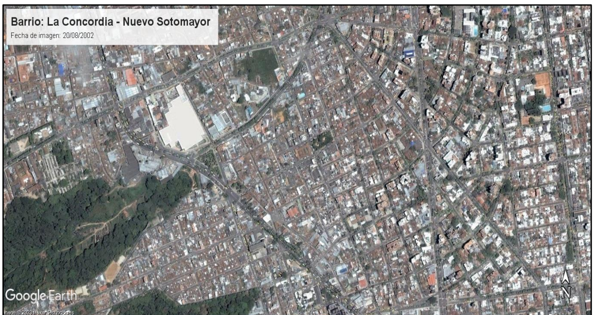
Figura 4. Vista aérea de los barrios La Concordia y Nuevo Sotomayor, Bucaramanga. Año 2002
