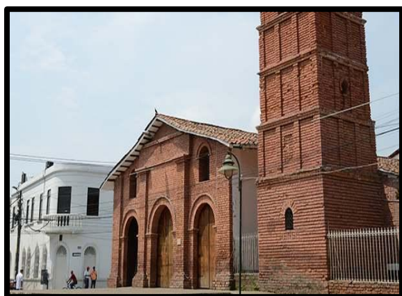
imagen 40 Parroquia antes de su demolición
