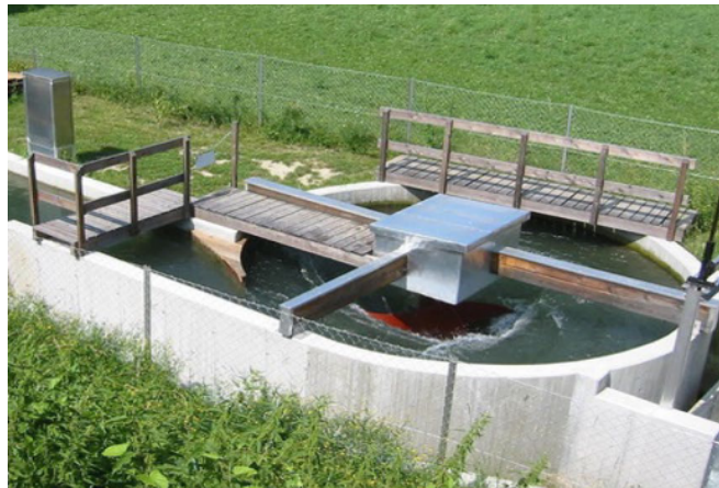
Figura 2.6: Planta hidrogeneradora de vórtice vertical instalada en Obergrafendorf, Austria. Fuente: [42].
