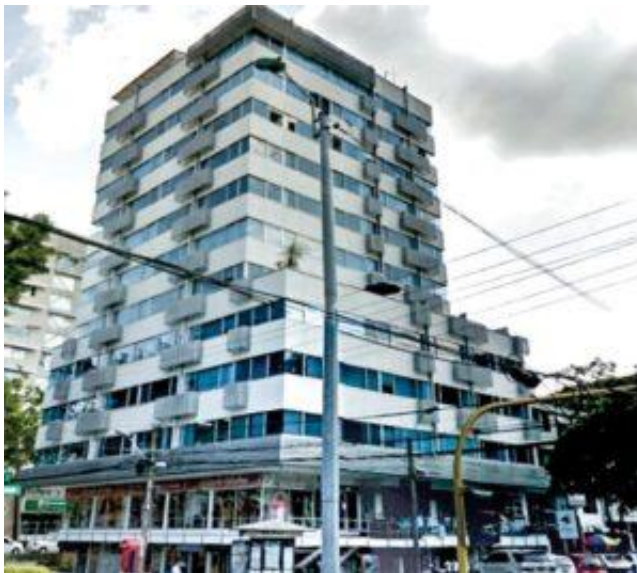
Figura 23. Sede Norte de Orthopacífico en Cali, Colombia
