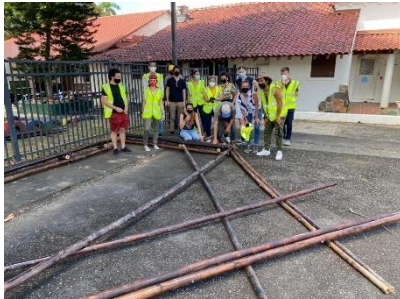
Ilustración 70 -Practica constructiva curso CD - Pórtico en bambú. Fuente: Ilustración propia.
