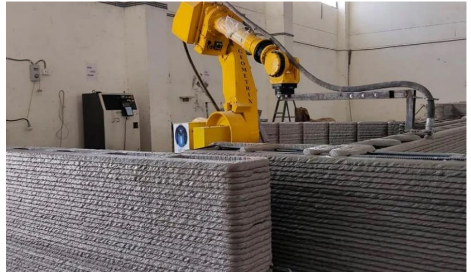
Ilustración 39 - Fabricación aditiva. Adición de diversas capas de hormigón para la formación de paredes. Fuente: https://www.cdt.cl/micob-y-su-tecnologia-de-impresion-3d-de-hormigon-aplicada-al-ambito-civil-y-militar/
