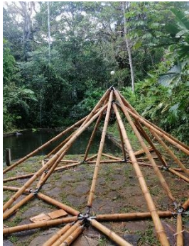
Ilustración 65 - Practica constructiva. Sistema reticular espacial. Fuente: Ilustración propia.
