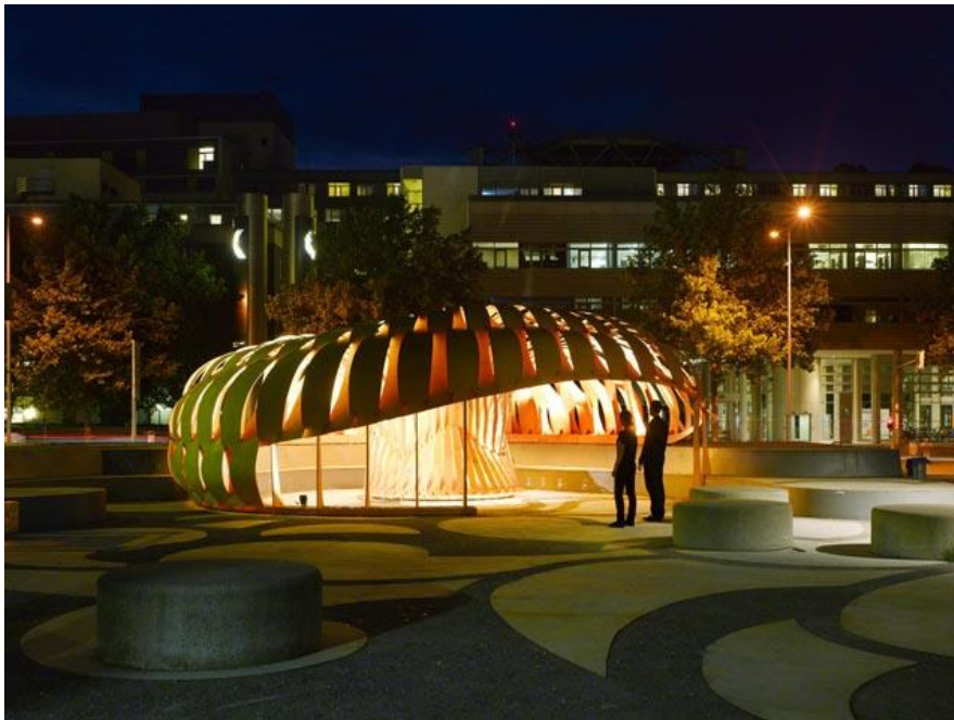
Ilustración 20 - Pabellón de Investigación ICD/TKE 2010. Fuente: http://www.achimmenges.net/?p=4443
