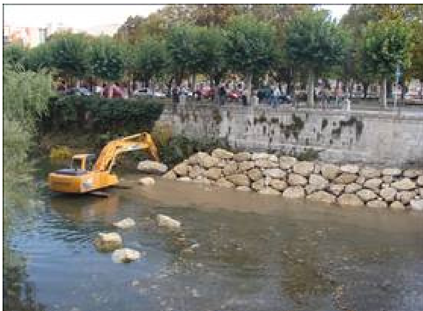
Figura 5.6 Protección de orilla con Enrocado o Rip – Rap
