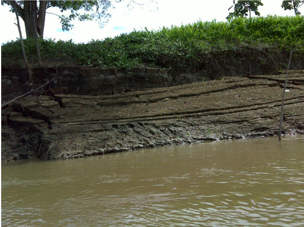
Foto 3.4 Barra de arena en proceso de remoción en masa sobre margen izquierda del río Cauca
