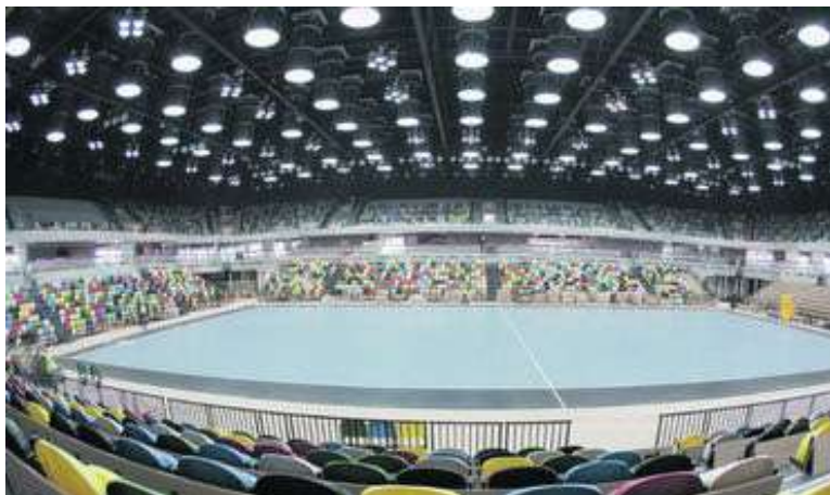
Imagen 31. Iluminación natural por ductos de luz.
