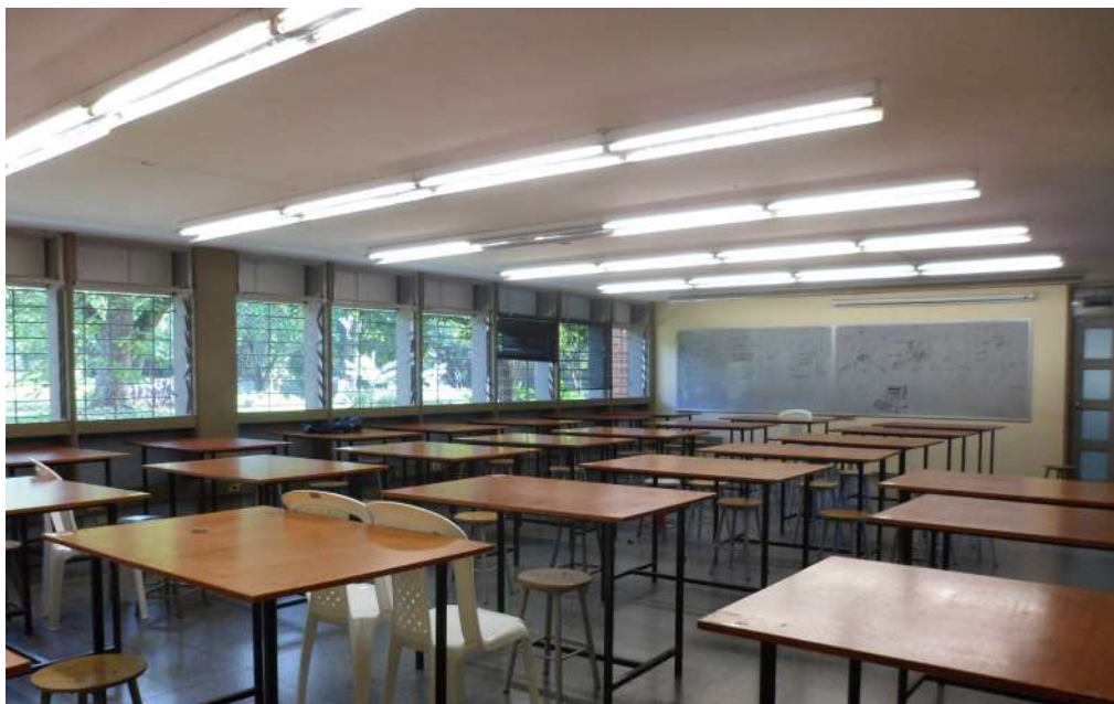
Fotografía 2. Mal Aprovechamiento de la iluminación en zonas donde no transitan personas- Salón de Arquitectura Primer Piso.
