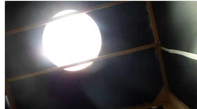
Fotografía 23. Vista al interior de la caja con ducto de luz natural.
