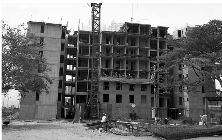
Figura 1. Sistema constructivo de muros de CR en Colombia. Fuente: (Jiménez et al., 2016).
