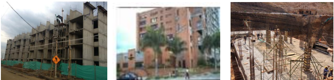
Imagen 17. Fotos obras GAMBOA CONSTRUCTORES SAS
