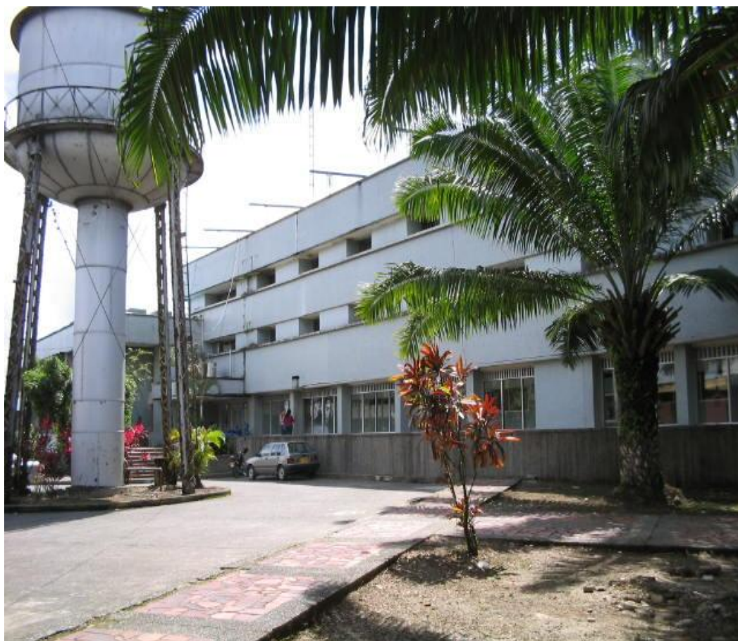
Fotografía 2. Fachada Posterior Hospital Departamental de Buenaventura
