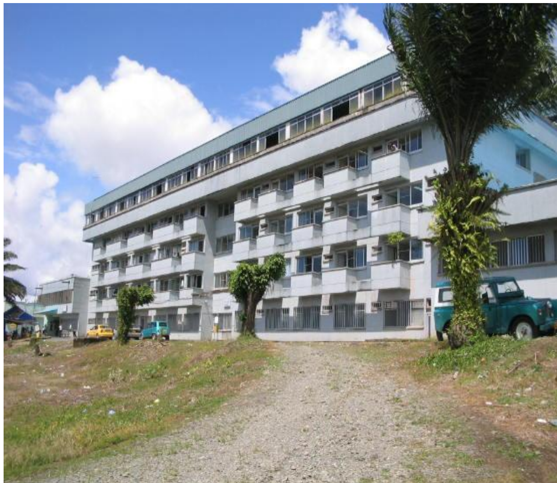
Fotografía 3. Fachada Lateral sur occidente Hospital Departamental de Buenaventura
