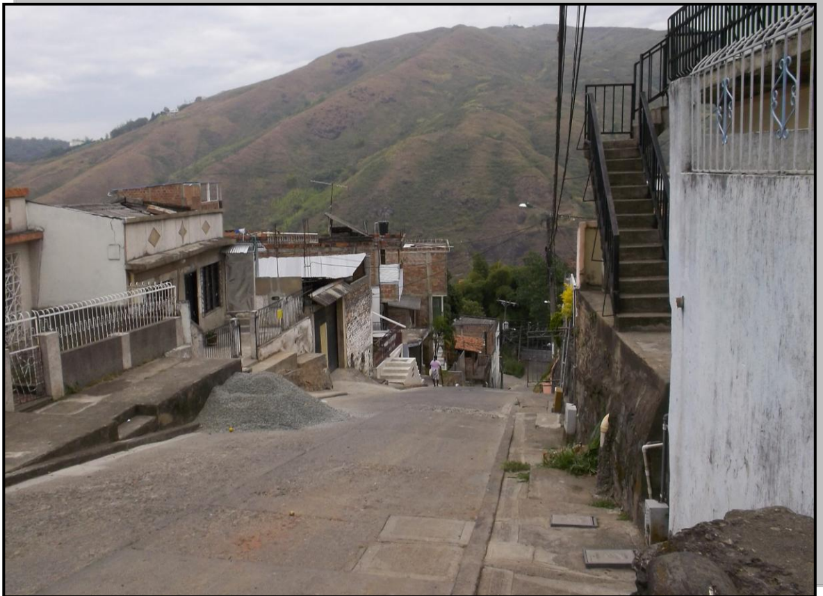
Fotografía 7. Viviendas construidas en cemento en Alto Palermo (Calle 21 Oeste entre Avenida 4ta A Oeste y 4ta Oeste).
