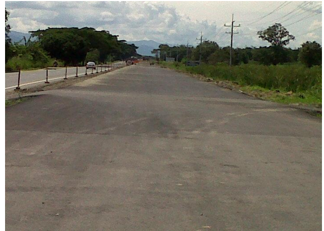
Fotografía 6. Calzada nueva vía La Paila – Zarzal (Valle)
