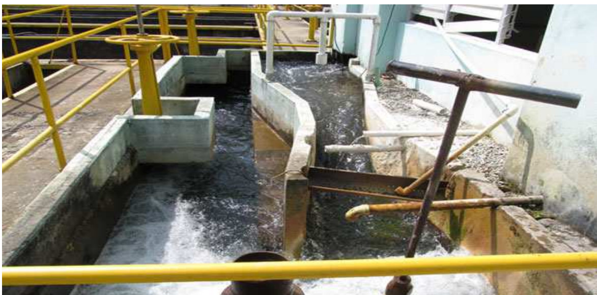
Figura 2: Fotografía del Acueducto de Santander de Quilichao
