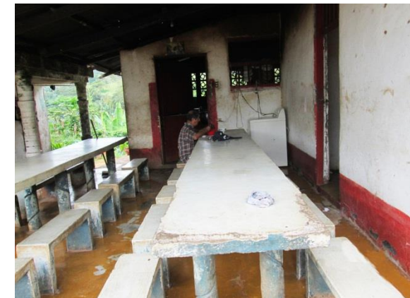
FOTO 22. Comedor de los trabajadores de la finca Costa Rica.
