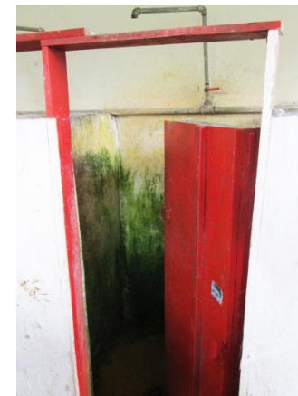
FOTO 25. Duchas utilizadas por los trabajadores de la finca Costa Rica.
